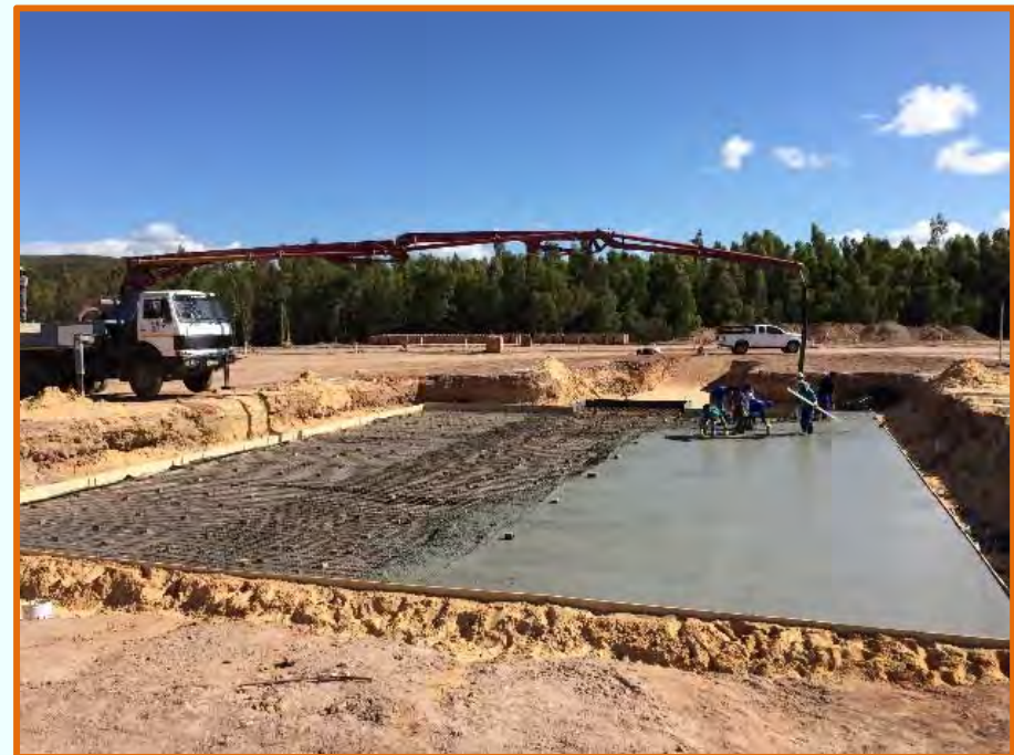
Kiln Foundation Concrete Pour
